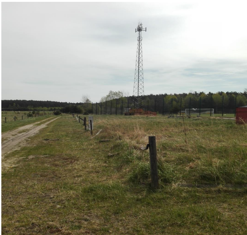
Stacja bazowa telefonii komórkowej w m. Zdziary.
