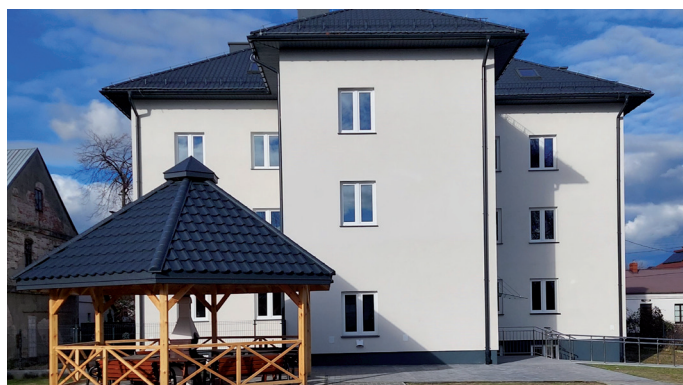
Budynek Centrum Opiekuńczo-Mieszkalnego w Ulanowie
