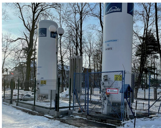
Rozbudowa i modernizacja instalacji tlenowej SPZZOZ w Nisku
