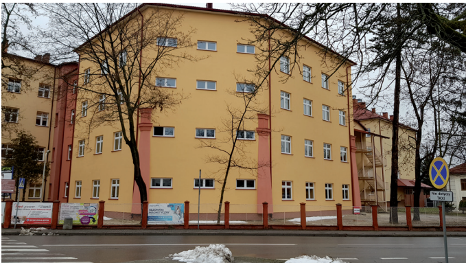
Rozbudowa i przebudowa części Szpitala Powiatowego im. PCK w Nisku
