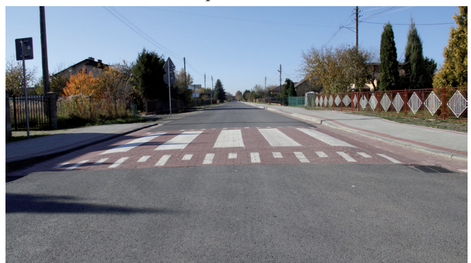
Przebudowana droga powiatowa Nr 1077R ul. Kończycka w Rudniku nad Sanem
