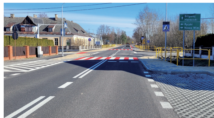
Przebudowana droga powiatowa Nr 1069R od drogi 858 - Krzeszów
