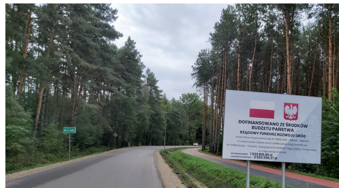
Przebudowana droga powiatowa Groble - Krzywdy
