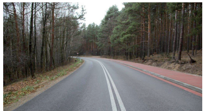
Przebudowana droga powiatowa Nr 1048R Zdziary - Banachy
