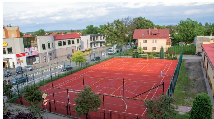
Wyremontowane boisko wielofunkcyjne przy LO w Nisku
