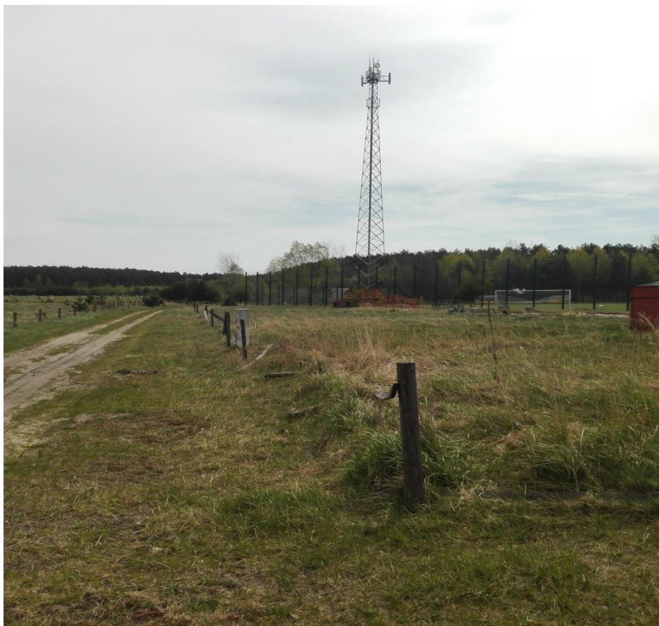
Stacja bazowa telefonii komórkowej w m. Zdziary.
